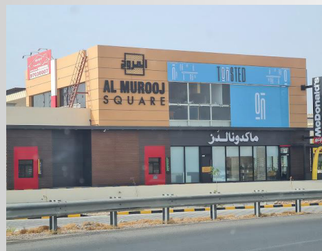
AL MUROOJ SQUARE ALKHOUDH
